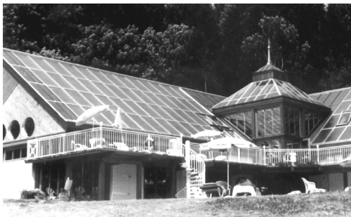
Obr. 2 Kolektory na pultovej streche
