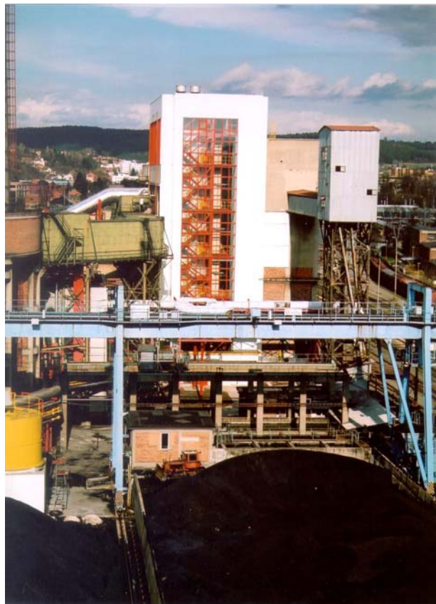
Pohľad na kotolňu kotla s CFV 125 t/h Moravské teplárny Zlín
