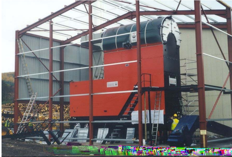
Obrázok 2 3MW t kotol na spaľovanie dreva využívaný na vykurovanie sušiareňských pecí
